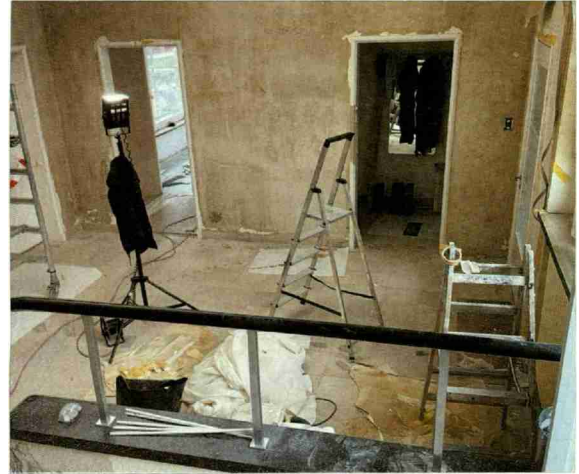
Original-Kalksteinboden anstatt rotem Teppich in der Eingangshalle.
